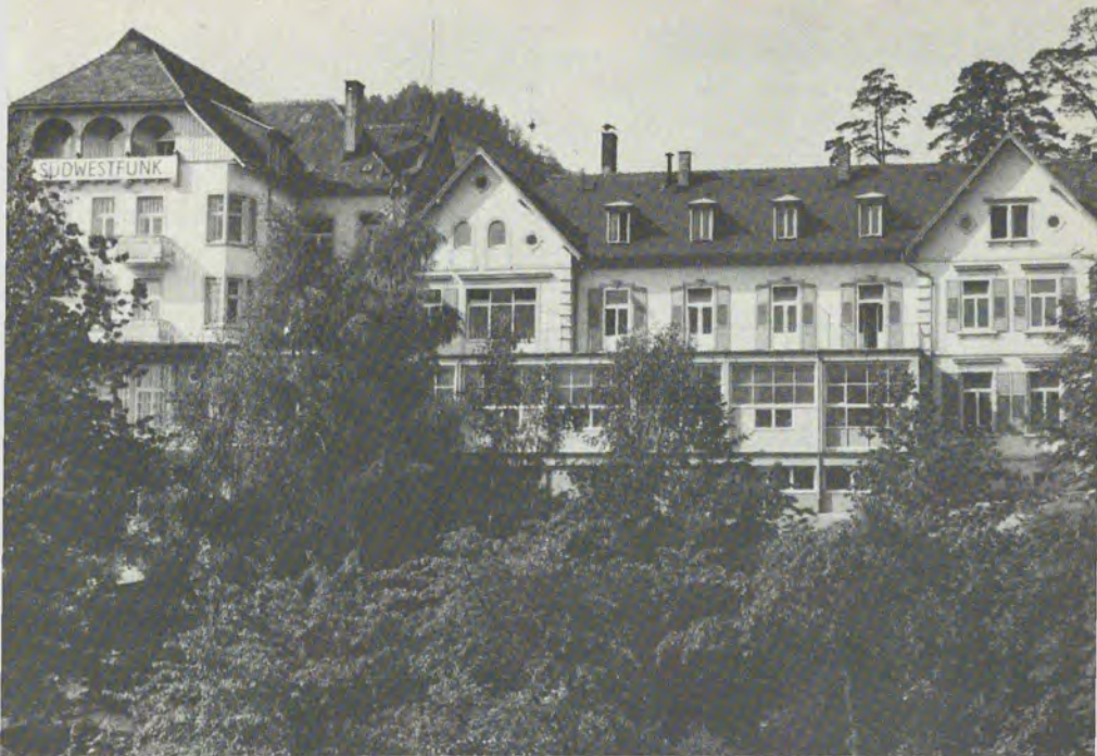
Das ehemalige Hotel Kaiserin Elisabeth in Baden-Baden, heute Sitz der Verwaltungsdirektion des Südwestfunks
