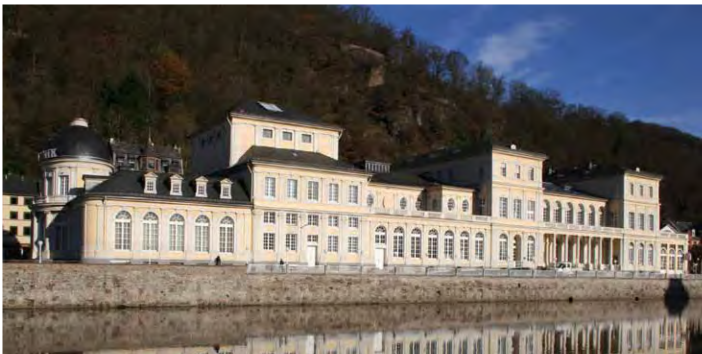
Bad Ems: Kurhaus, erbaut 1836-39; 1912/13 (2009)
