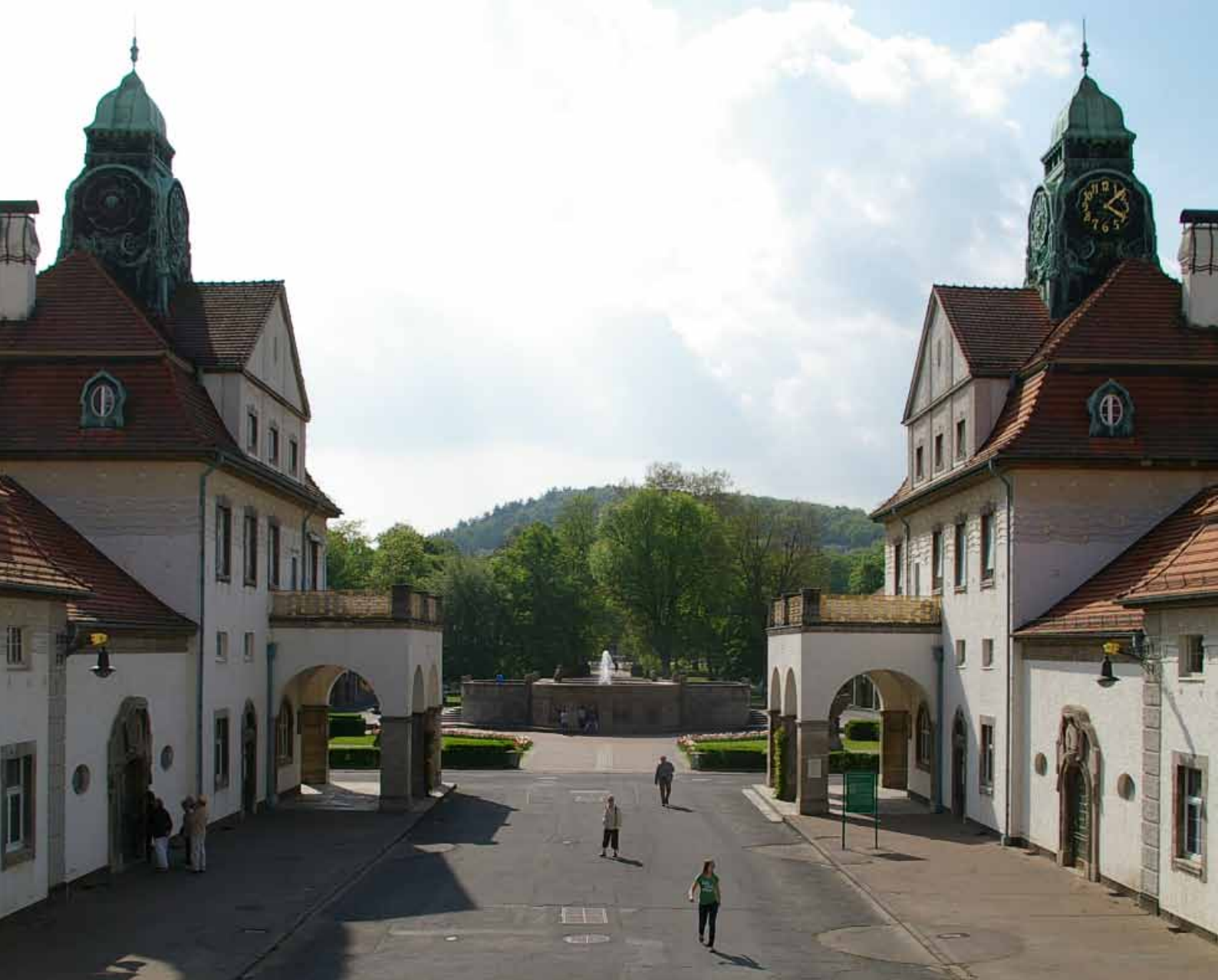
Bad Nauheim: Sprudelhof, Wilhelm Jost, 1905-1912.
