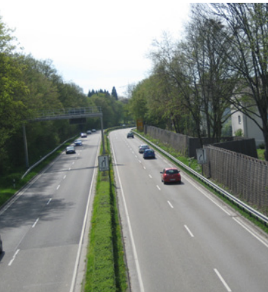
Lärmschutzwand entlang Europastraße B 500
