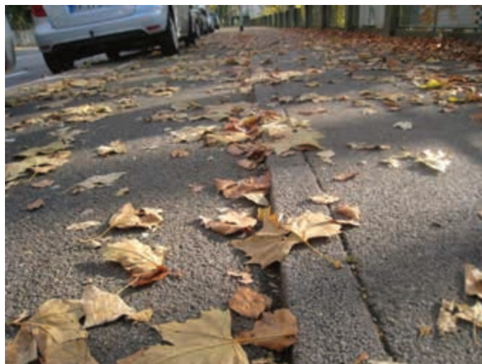
Abb. 5-18: Bauliche Trennung von ehemaligem Radweg zum Gehweg im Zuge der Rheinstraße. Mittlerweile als Gehweg, Radverkehr frei ausgewiesen.
