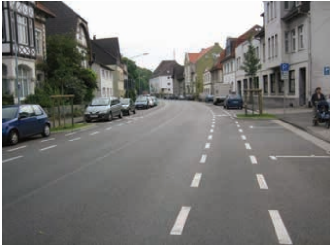
Abb. 2-9: Schutzstreifen mit Sicherheitstrennstreifen zu parkenden Kfz (Lemgo)
