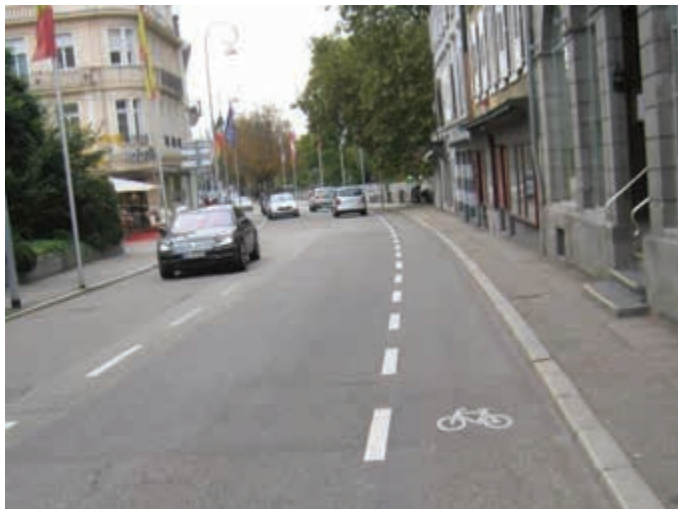
Abb. 2-10: Schutzstreifen in Baden-Baden (Lange Straße)
