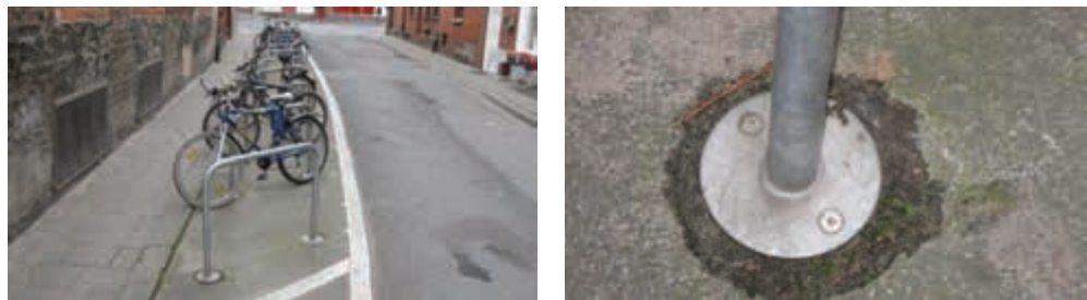
Abb. 3-5: Beispiel für verschraubte Rahmenhalter (Lüneburg)
