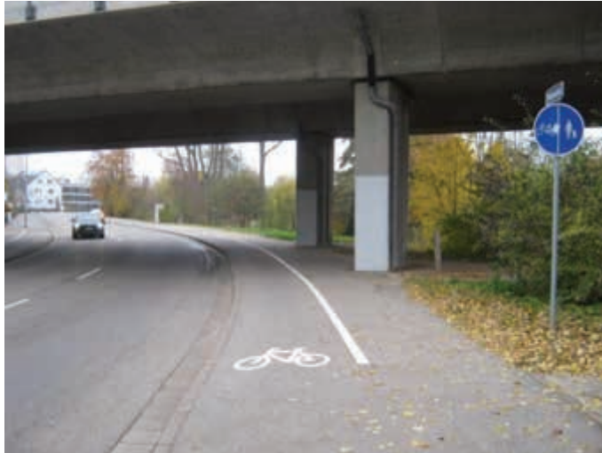
Abb. 2-4: Benutzungspflichtiger baulicher Radweg (Baden-Baden, Schwarzwaldstraße, Benutzungspflicht inzwischen aufgehoben)
