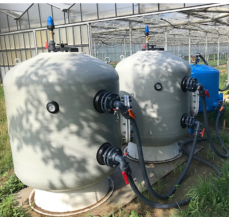
In den beiden hellen Filtern wird das Beregnungswasser gereinigt, Foto Decker
