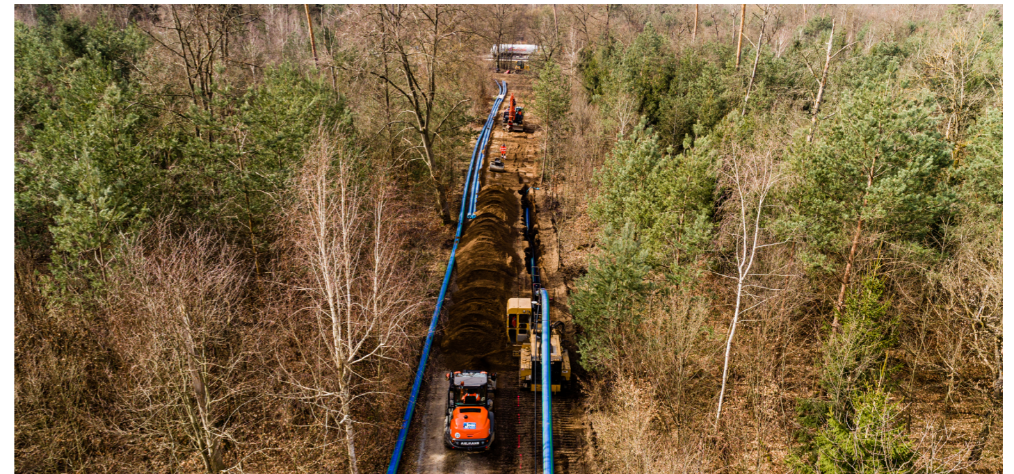
Verundleitungen werden verlegt, Drohnenaufnahme, mit freundlicher Genehmigung der Stadtwerke Baden-Baden
