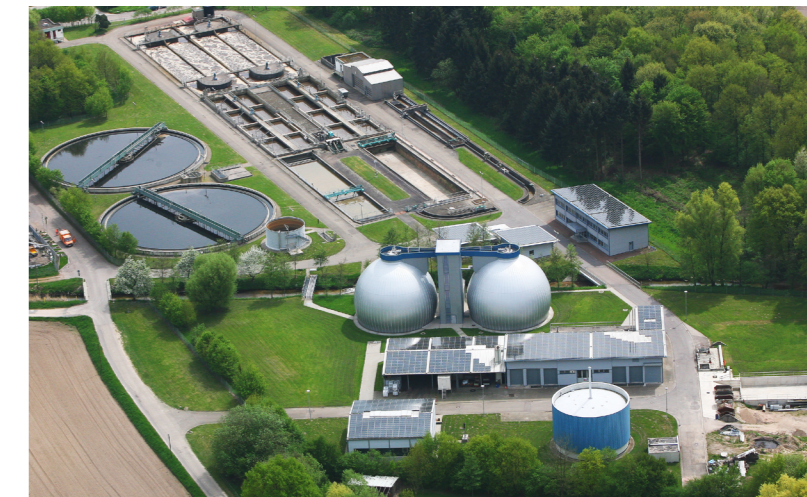
Kläranlage in Bühl - Quelle Abwasserzweckverband Bühl und Umgebung
