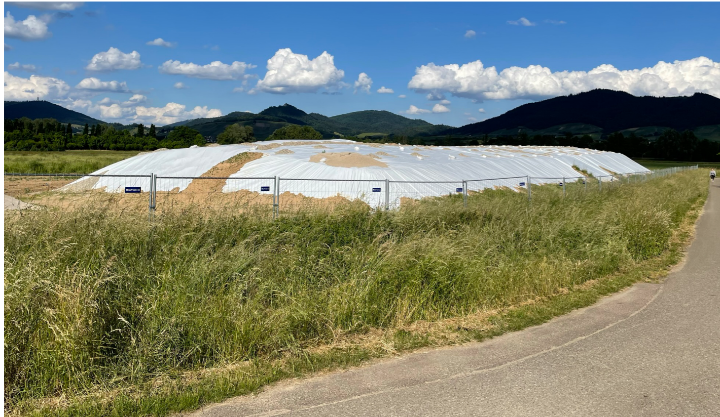
PFAS-belastete Erde wird in den Bußmatten zwischengelagert und dann eingebaut, Foto Klatt
