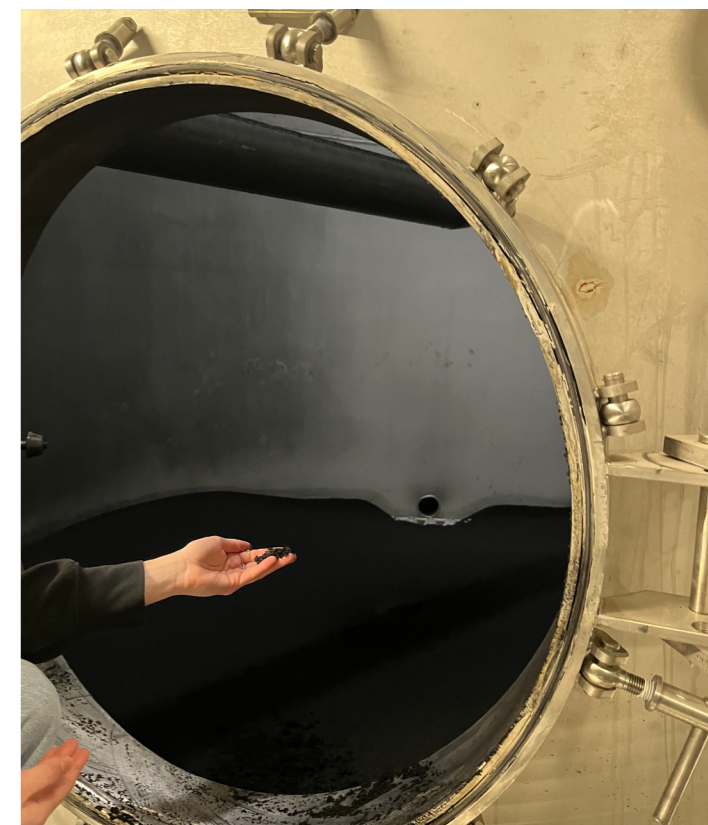
Blick auf die Aktivkohle im Behälter, Foto Adam
