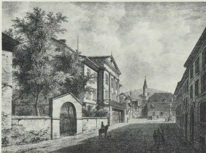
Blick auf das Großherzogliche Palais
