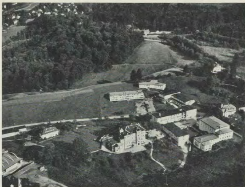
Die Funkhöhe Baden-Baden: Im Vordergrund rechts das große Musikstudio mit den Büros der Abteilung Musik. Links davon ein Gebäude für verschiedene Redaktionen und technische Abteilungen. Den Hof des Funkgeländes schließt das große, querstehende, fünfstöckige Haupthaus ab, in dem sich die Intendanz, die Programmdirektion, verschiedene Abteilungen und die Sendekomplexe für Mittelwelle und Ultrakurzwellen, sowie die Betriebsaufsicht befinden. Der rechte Teil des Gebäudes enthält den großen und kleinen Sitzungssaal. Hinter dem Haupthaus schließt sich das Unterhaltungsstudio mit einem Sendesaal, Büroräumen und den Studioräumen des Hörspiels an. Dahinter zeigt das Bild das in Dreispitzform gebaute Casino der Funkhöhe. Links erstreckt sich das Haus der Technik; am linken Bildrand die Fahrbereitschaft und das Haus des Werbefunks.
