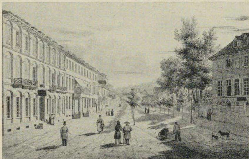
Der »neue Graben«, die heutige Sofienstraße und künftige Bäderallee
