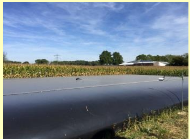
Flexibler, geschlossener Großspeicher 500 m³ Foto: B. Kaiser Regierungspräsidium Karlsruhe
