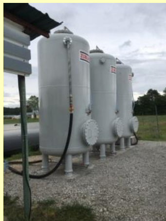
Silos mit Aktivkohle Foto: A. Stief Landwirtschaftsamt Rastatt
