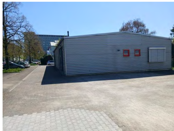
Abbildung 24: Versiegelte Fläche im Nordwesten
