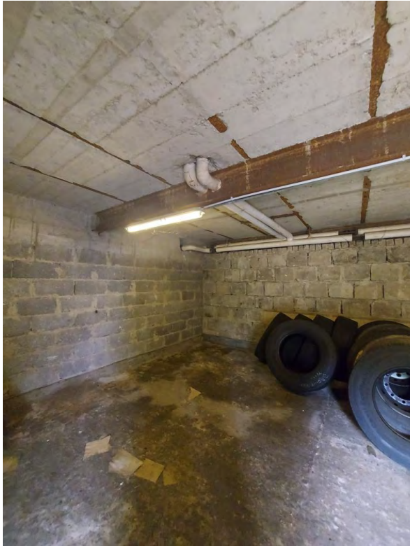
Abbildung 17: Nicht frei zugänglicher Keller im südwestlichen Gebäude
