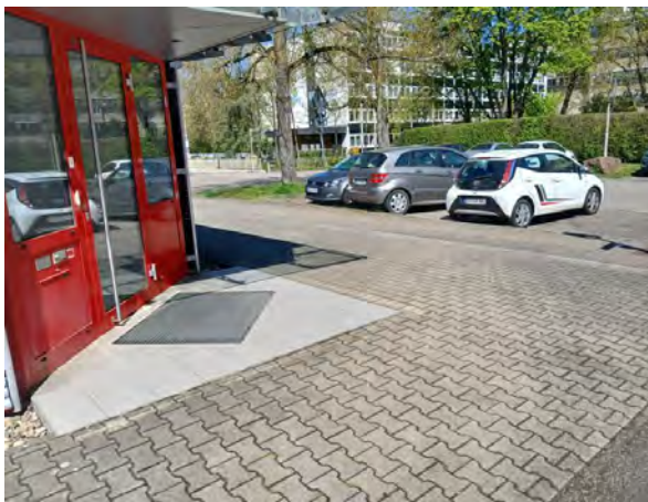
Abbildung 23: Eingangstür des nordwestlichen Gebäudes
