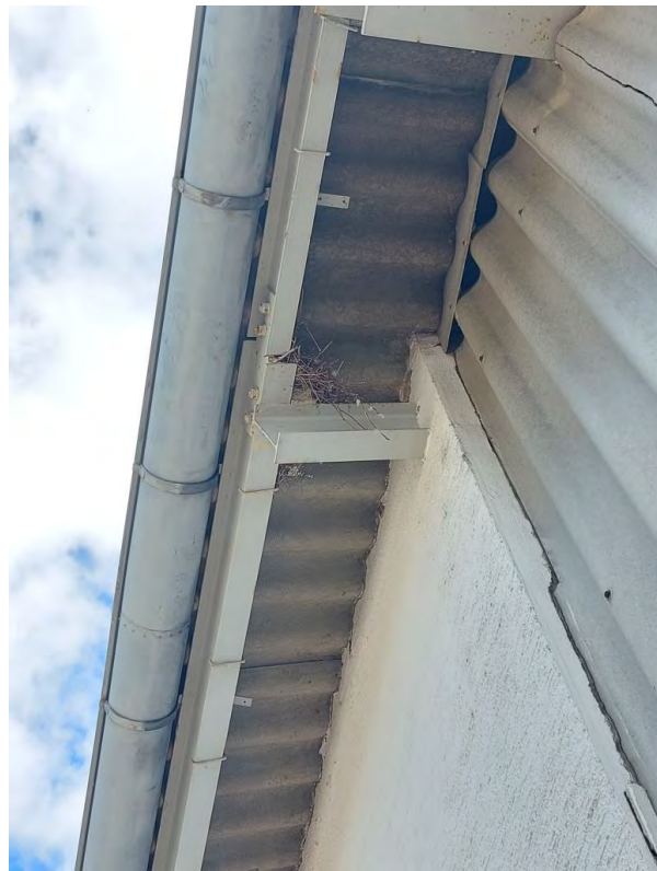
Abbildung 14: Nest der Straßentauben an Lagerhalle
