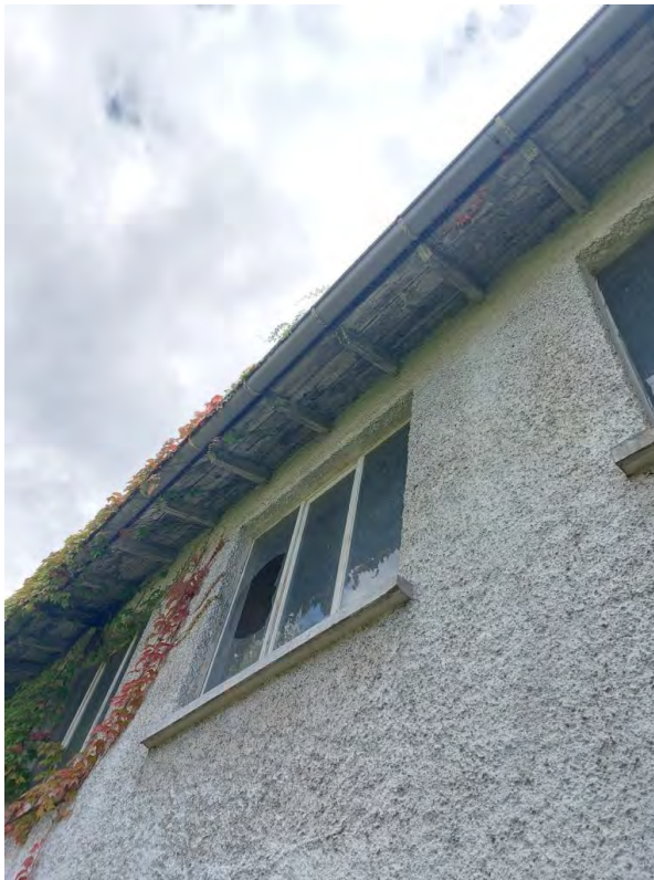
Abbildung 13: Anschluss an Dachüberstand am südwestlichen Gebäude bündig verputzt
