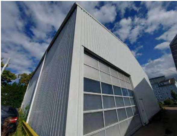
Abbildung 19: Aus Wellplatten gebautes Gebäude zwischen Empfangsgebäude und Oliverstraße
